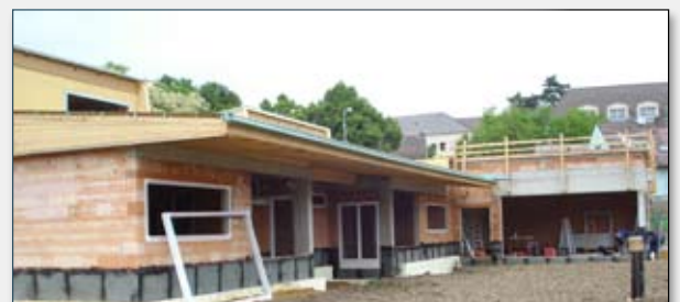
Der Neubau des Kindergartens wird bis September 2010 fertiggestellt sein.
