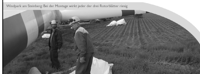
Windpark am Steinberg: Bei der Montage wirkt jeder der drei Rotorblätter riesig
