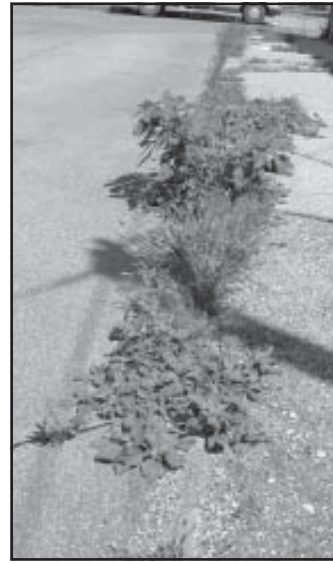
Musterbeispiel für eine "Bio-Gehsteigkante", wie sie nicht sein soll. Die Randsteine sind nicht mehr zu erkennen
