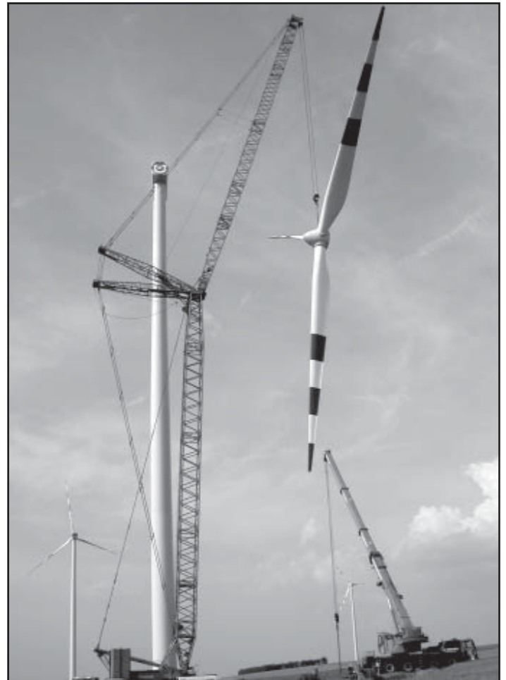
Der Zusammenbau eines Windrades: Für den Kran Schwerarbeit, wobei hauptsächlich das Können des Kranführers gefragt ist.
