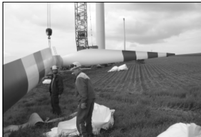
Bei der Montage wirkt jeder der drei Rotorblätter riesig
